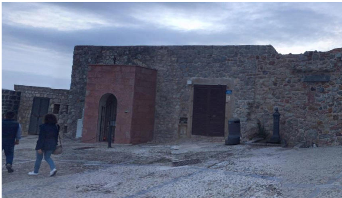
Fig. 23 – Viste di dettaglio del tratto di costa interessata dalla proposta di revisione della dividente demaniale
