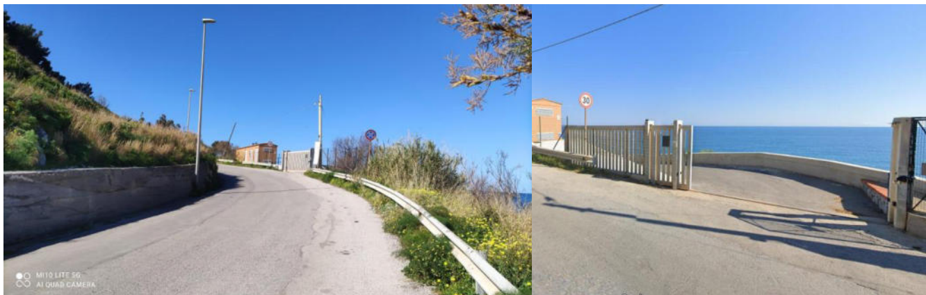
Fig. 20 – Viste di dettaglio del tratto di costa interessata dalla proposta di revisione della dividente demaniale
